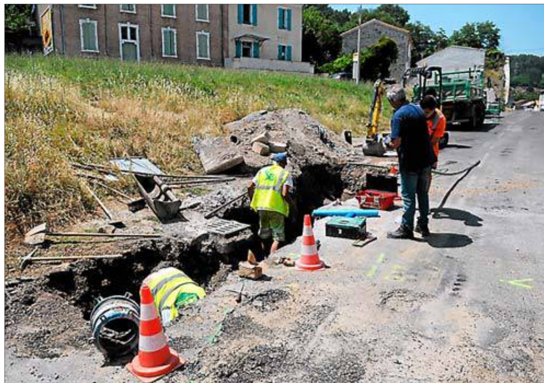
■ Effectuée sous la chaleur, la réparation a permis de remettre l'eau l'après-midi. A. BÉTHUNE
